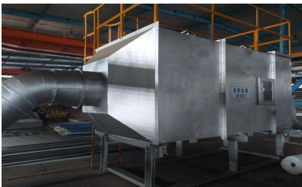
圖三、活性炭吸附設備—物理性吸附，使用活性炭吸附劑來分離氣體。在低溫、濃度低，且無水氣的情況下，活性炭設備具有良好的吸附效率。
