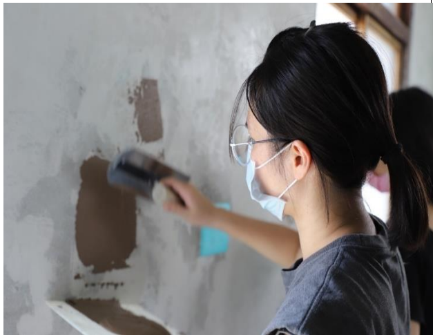
圖一、主要進行修繕壁癌的問題，並使用新建材材料<樂土>。
