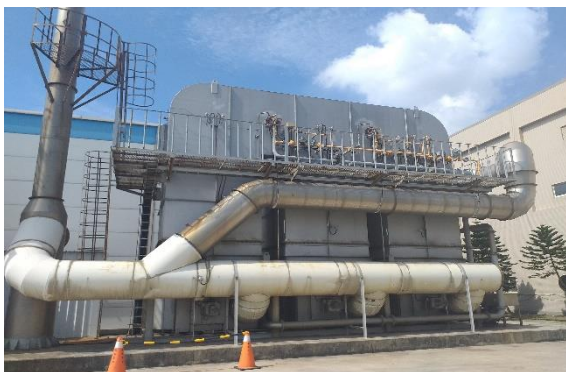
圖一、RTO—利用陶瓷蓄熱材的蓄熱功能，將焚化產生的廢熱利用轉換處理方式重複進行熱回收，熱回收效率可達 95%，相比起來更有效率。
